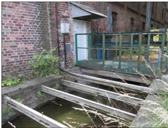
Fragment młyńskiego budynku od ul. Browarnej i kanał dostarczający kiedyś wodę z Cybiny do poruszania turbiny.
