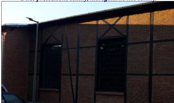
Ragment zrewitalizowanej parowozowni z pruskim murem
