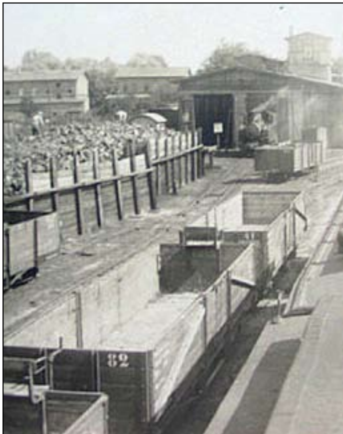
Na tym zdjęciu stacji towarowej Kobylepole sprzed drugiej wojny światowej widać budynek parowozowni, kolejowe budynki mieszkalne i po prawej u góry słabo widoczny zarys wieży pałacu Mycielskich.
