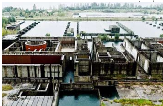
Niedokończona budowa elektrowni atomowej w Żarnowcu
