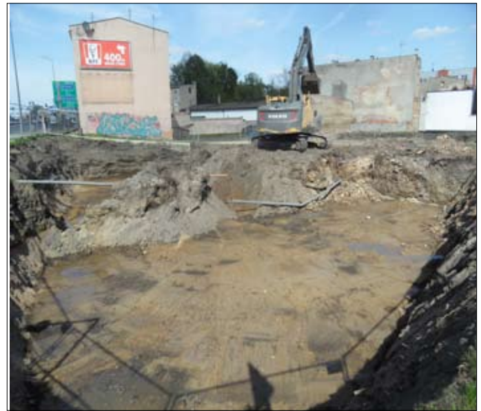
W narożniku ulic Sucha i Gdynska powstaje wielorodzinny budynek z podziemnym garażem.
